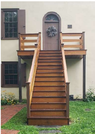
Nitre Hall's new steps
